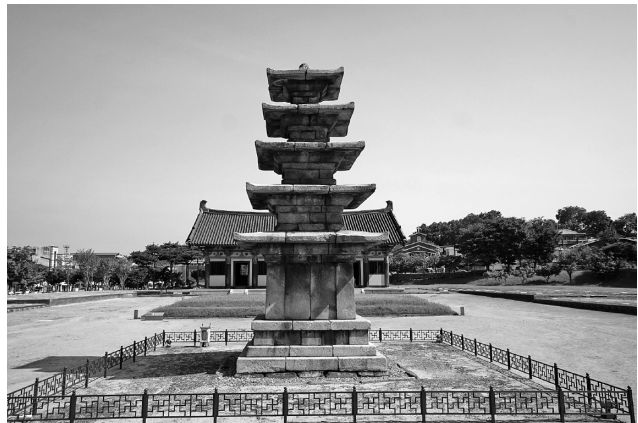
【図5-2】 定林寺址の五層石塔 (田中撮影)
